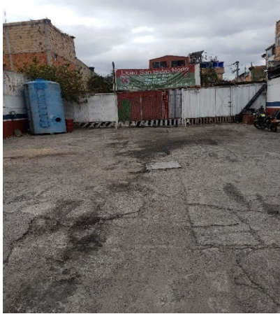
Fotografía 3. Construcción del colegio donde aparentemente se ubica el pozo de código pz-11-0017
