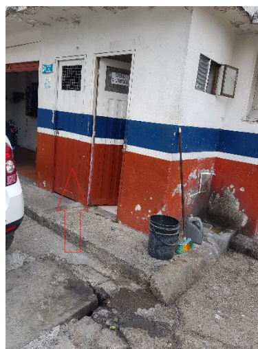
Fotografía 2. Cuarto que funciona como cocina y contiene el pozo pz-11-0187
