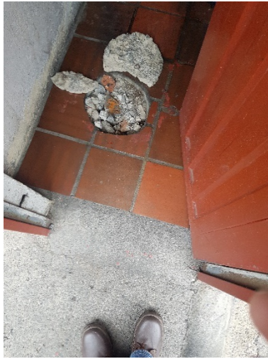
Fotografía 1. Localización del pozo pz-11-0187
