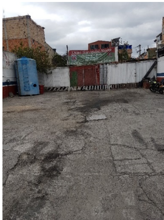
Fotografía 3. Construcción del colegio donde aparentemente se ubica el pozo de código pz-11-0017
